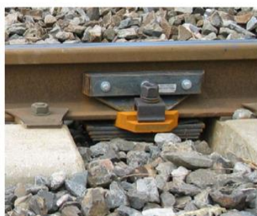
Absorbeur de vibrations sur rail (source SNCF)
